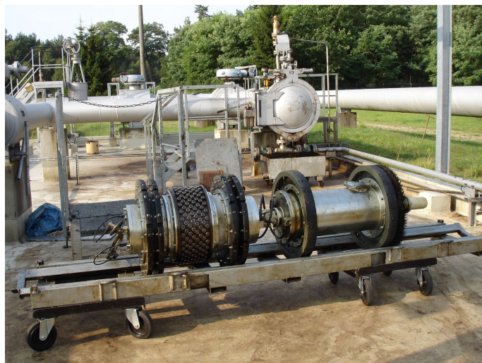
Fot. 1. Robot inspekcyjny do badania stanu technicznego rurociągów
