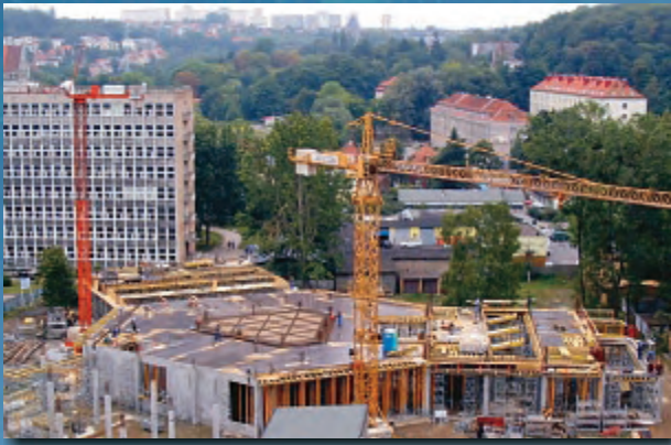
Budowa nowego budynku - gmachu WETI-B
